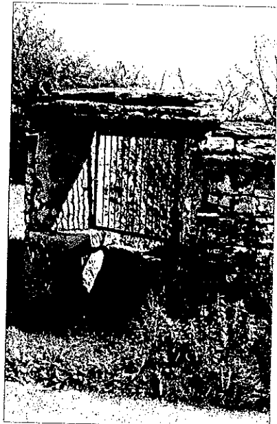
L'ouverture du puits.
