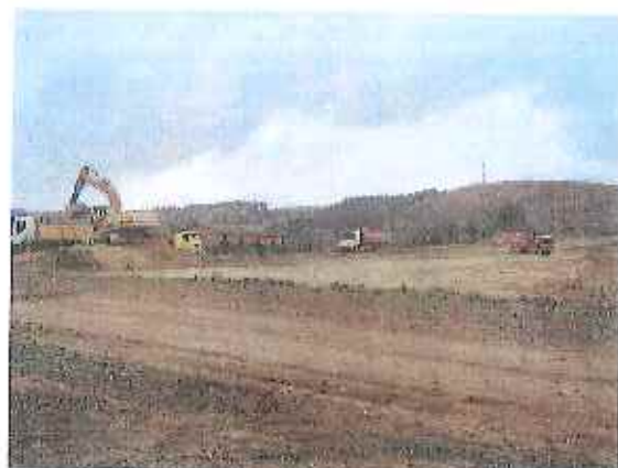
Terrassement de la Zone Artisanale
